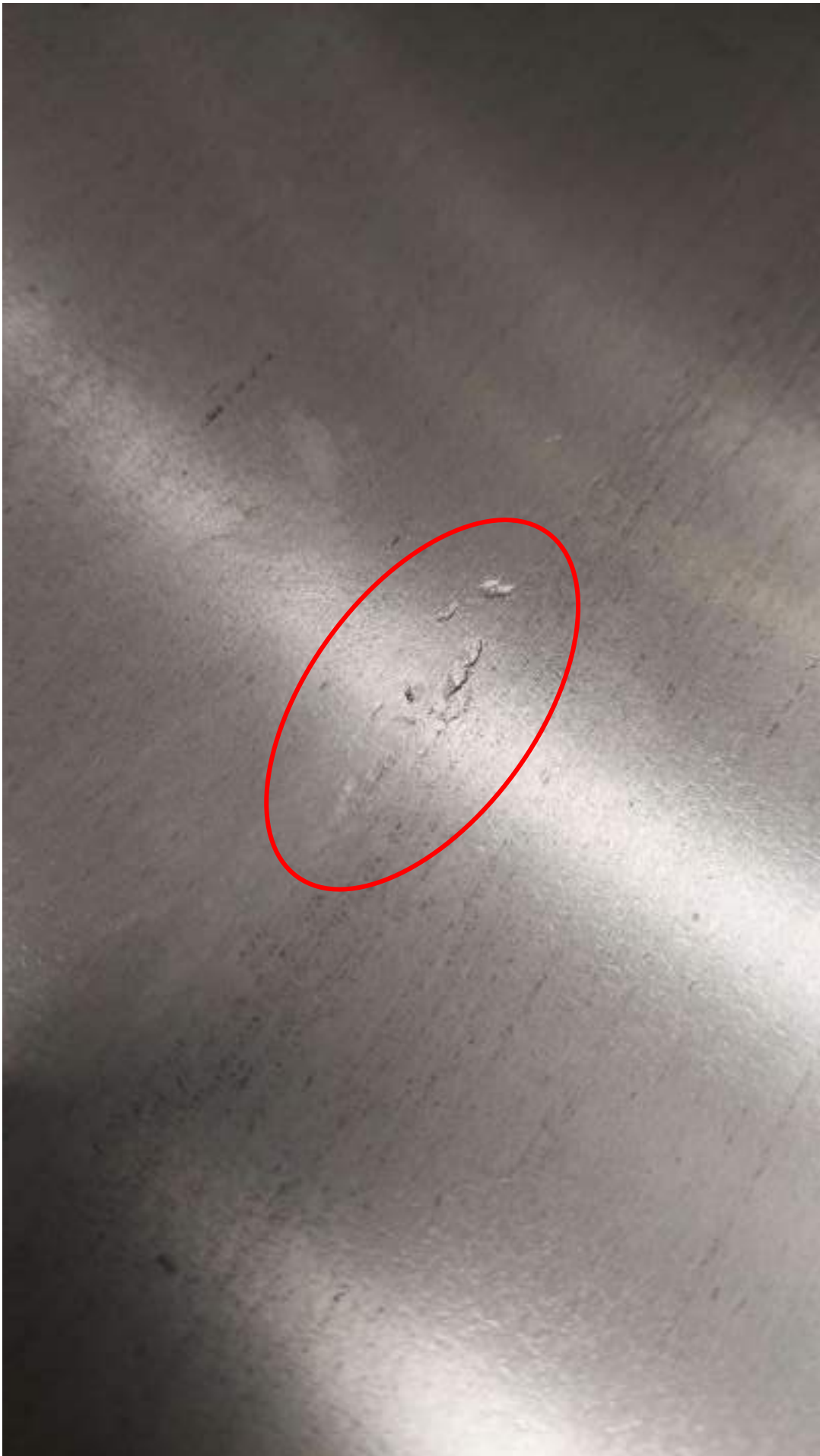
Додаток фото 8 (дефект від прокату)
